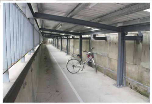
106年度科教樓外牆遮陽設施暨周邊腳踏車棚改善工程
