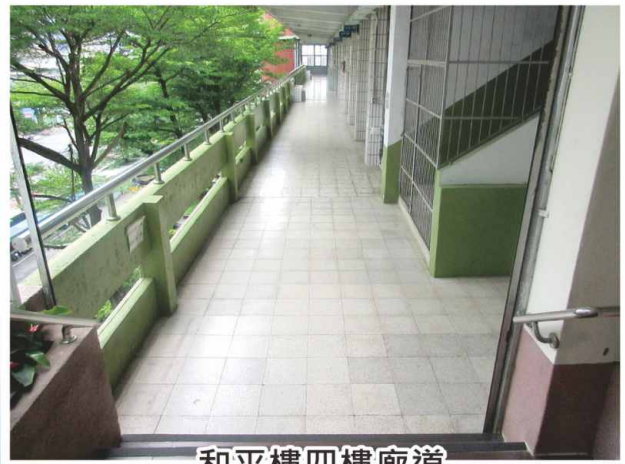
和平樓四樓廊道
